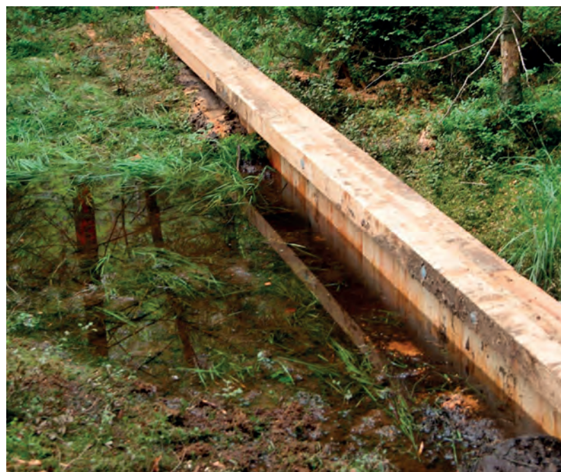
Die Stauwirkung ist schon kurze Zeit nach Errichtung des Dammes erkennbar. (Abb. 3)
