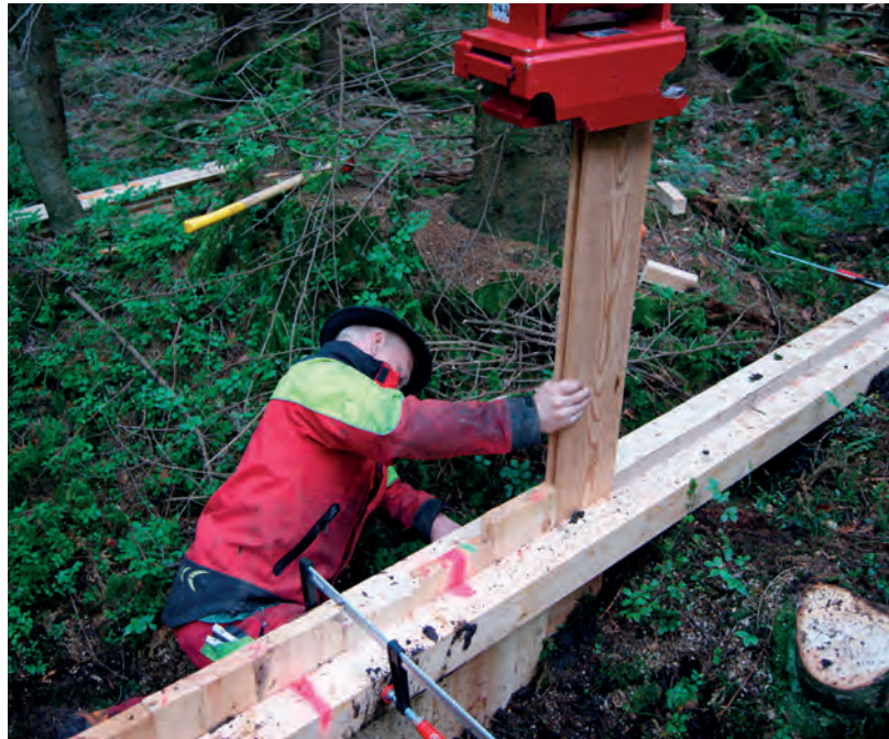
Die Pfosten werden mit dem Bagger in den Torfkörper gedrückt. (Abb. 2)
